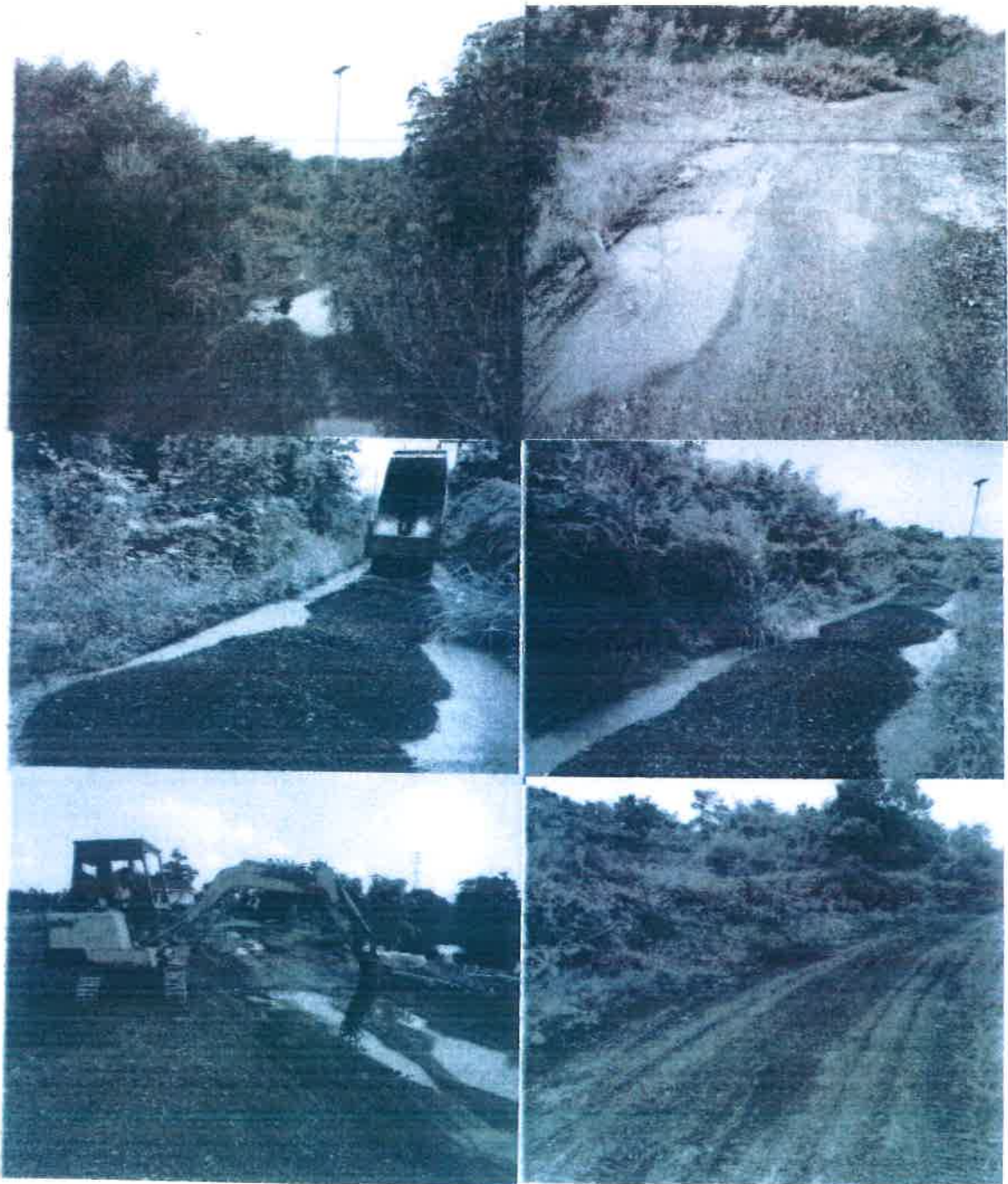
ภาพงานตัดหญ้าทางป่าและงานซ่อมแซมผิวทางที่เป็นหลุมบ่อ ถนนภายในบริเวณรอบสำนักงานฯ
